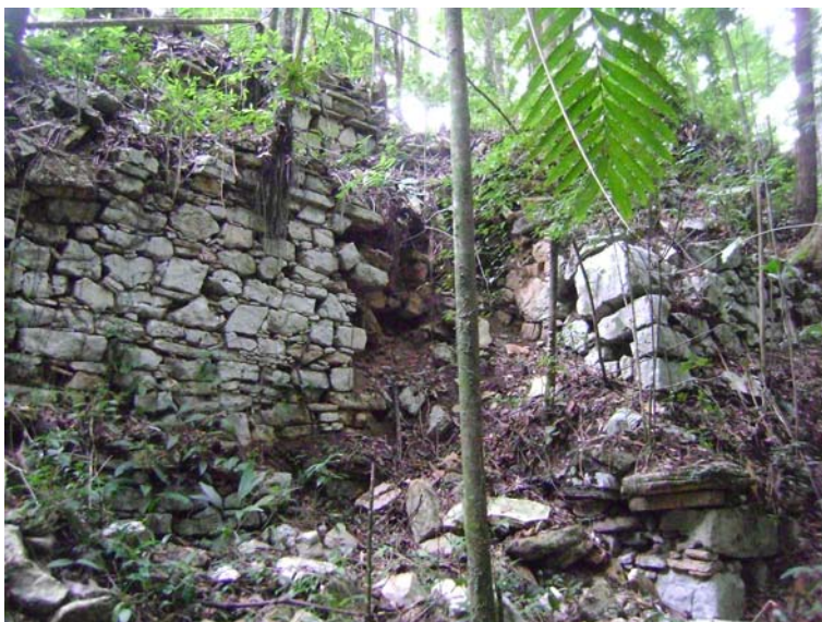
Fig.IV. 55 Frente sur del edificio A-9, en correspondencia de la junción entre las dos estructuras que conforman el edificio final (Foto E. Mirón)
