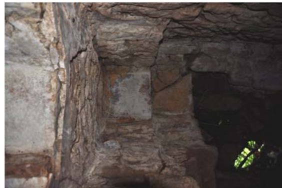
Fig.IV. 10. Crujía Este (3) del pasaje de las pinturas en donde se aprecia la secuencia de niveles para hospedar una escalera de subida (Foto I. Sprajc 2011)
