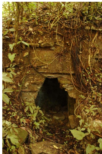
Fig.IV. 23. Entrada interior a las crujías Este del Palacio (Foto A. Flores 2010)
