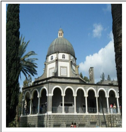
Iglesia de las bienaventuranzas al sureste de Corozáin
