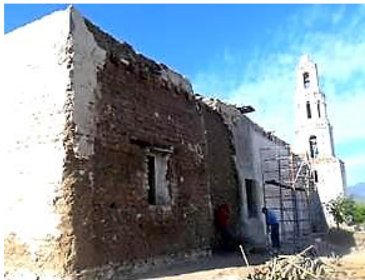
En los muros de adobe de la iglesia de Ónavas localizada en la pimería baja, de fábrica jesuita se observa un base de piedra para proteger el muro de la humedad y bien nivelada para iniciar la colocación de los bloques de adobe (Fotografía Centro INAH Sonora, Ónavas, noviembre de 2011)
