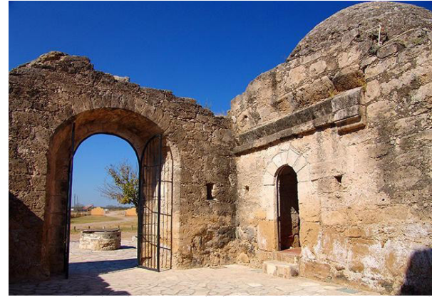
Vista desde el interior de la nave del acceso principal del templo de San Bernardo; a la derecha un pequeño arco de entra al bautisterio el cual esta techado con una bóveda de media naranja de cantera.
