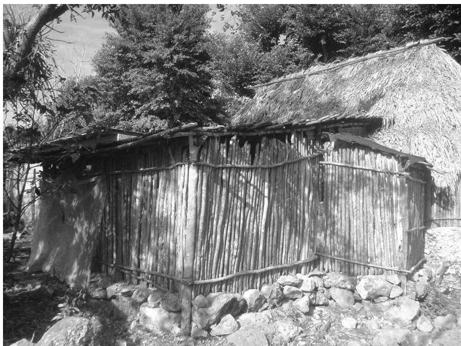
Figura 6.4. Plano del Solar 03 e imagen de los anexos adaptados como cocina y baño (foto del autor).
