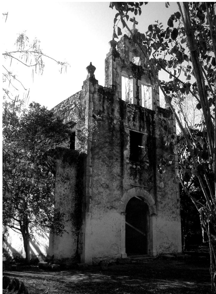
Figura 4.9. Iglesia de Yaxunah construida a principios del siglo XIX (foto del autor).
