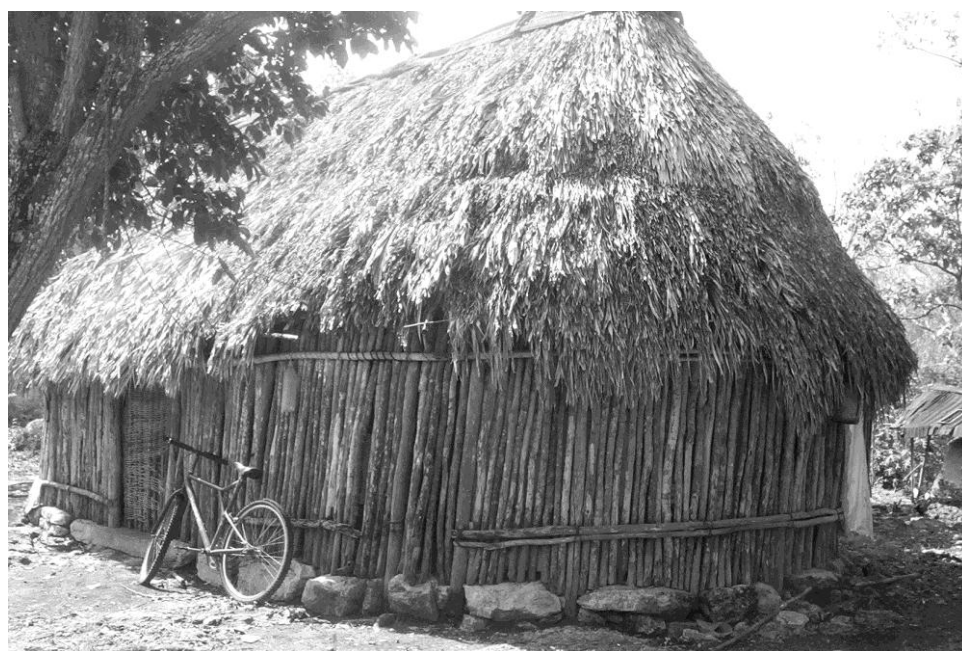
Figura 6.11. Plano del solar y casa absidal de bajareque y palma del Grupo Doméstico 10 (foto del autor). 199
