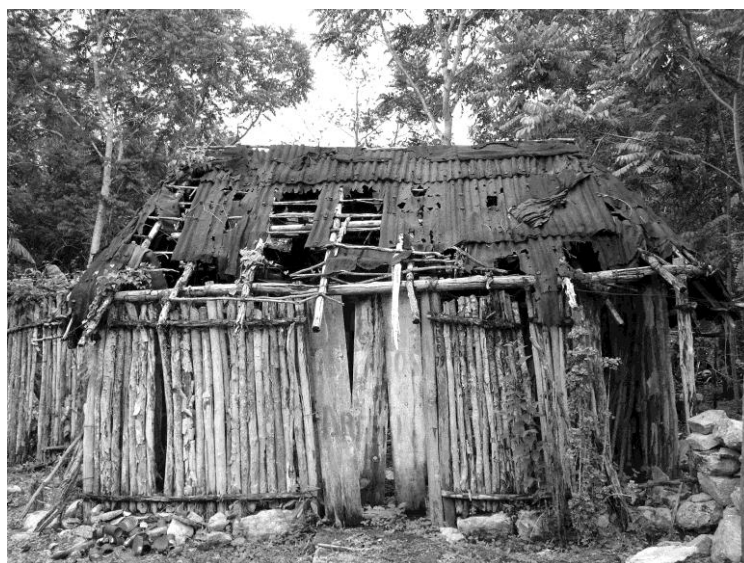
Figura 6.30. Plano del Solar 28 y la casa principal en proceso avanzado de deterioro (foto del autor).
