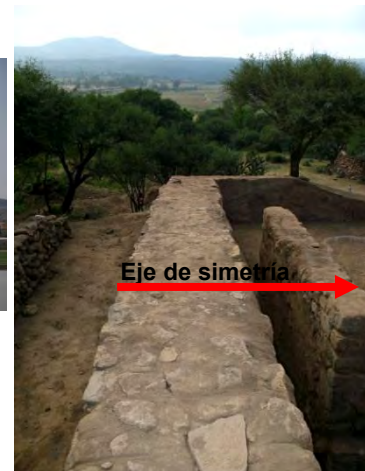
Figura 14. El muro norte-sur liberado y restaurado. Fotografía de Francisco Granados, abril de 2008.
