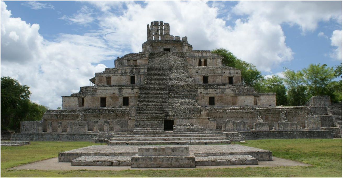
Figura 35.- Vista frontal del edificio de los cinco pisos.
