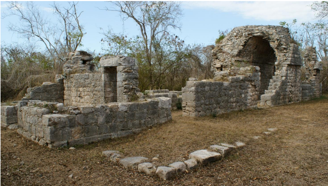
Figura 56.- Estructura 57, Dzibilchaltún, Yucatán.
