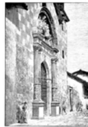
IMAGEN 7. Fachada de la Capilla de la Bordadita que hace parte del Claustro del Colegio Mayor de Nuestra Señora del Rosario
